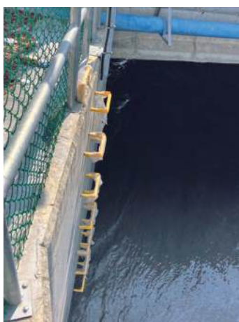
▲ 預埋式塑膠披覆 不銹鋼踏步(SUS304) 符合CNS 13206規範
